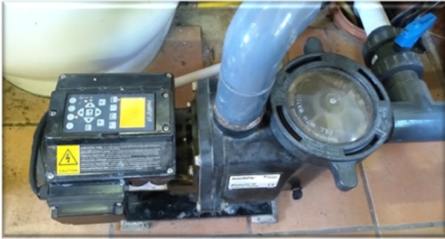
Abb.: Schwimmbadpumpe (eigene Aufnahme)
